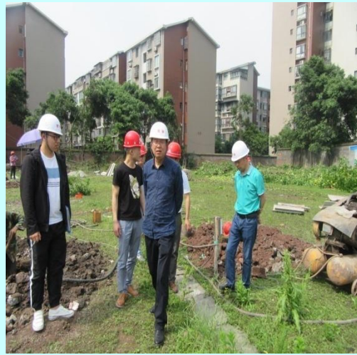
董事长、总工程师检查工地
