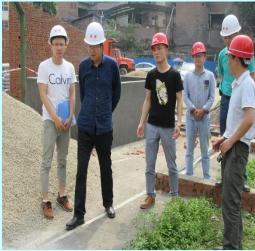
董事长、总工程师检查工地
