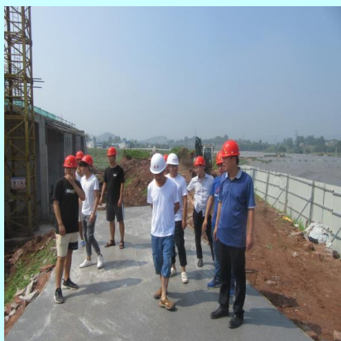
董事长（右一）总工程师（右二） 检查工地
